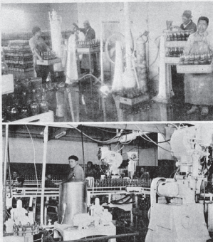
PRIMERAS MÁQUINAS A PEDAL. Esta fotografía es una muestra de cómo se inició el trabajo hace muchos años. Máquinas a pedal con las cuales se tornaba difícil la elaboración de refresco. En la segunda fotografía (abajo) se observa la máquina que remplazó a las otras de pedal. Y, finalmente, en la foto de la derecha se observa la moderna maquinaria que desplaza a las dos anteriores. Embotelladora "La Cascada" Ltda. está modernizando constantemente sus instalaciones y maquinarias.
